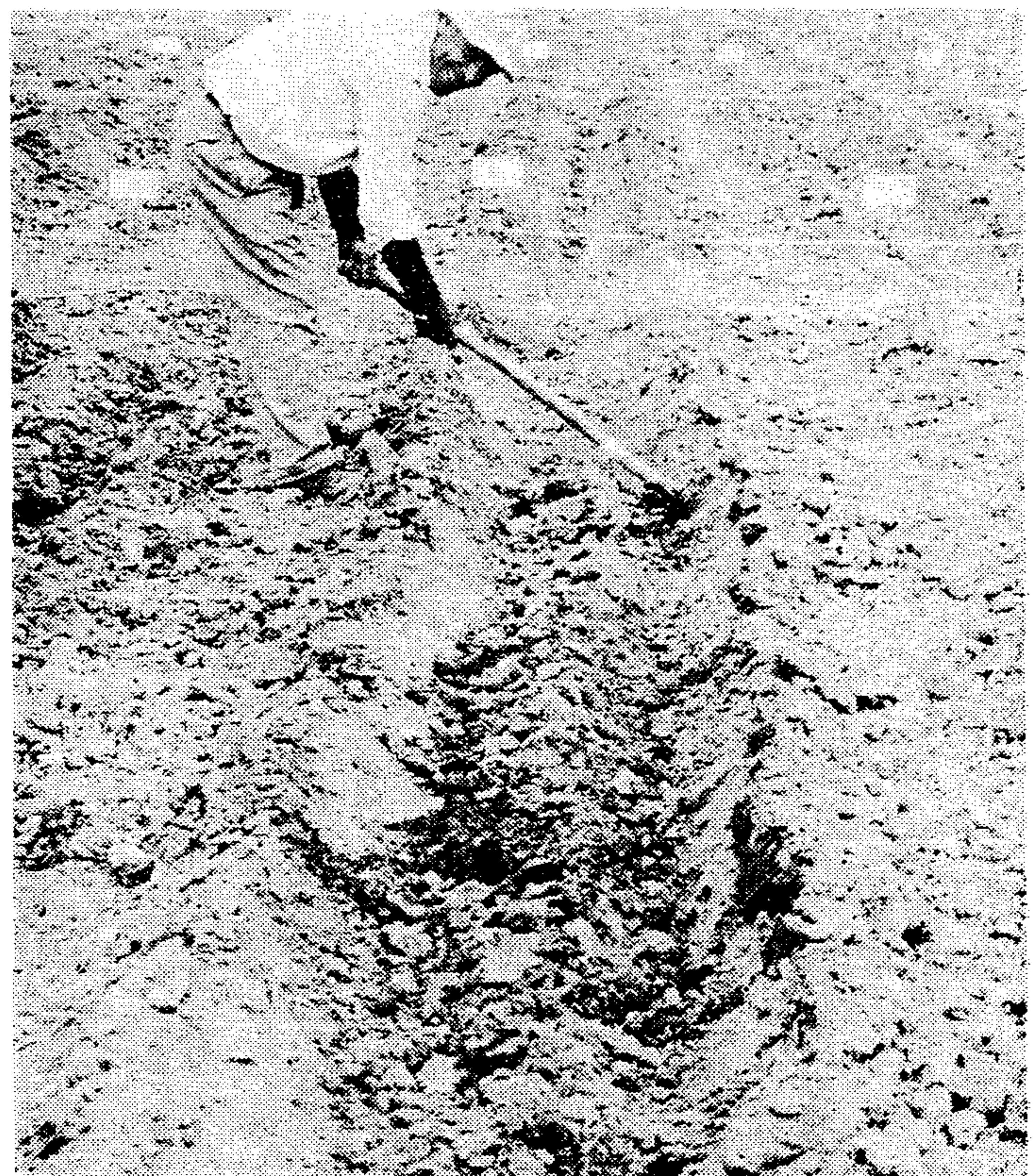
Δεύτερο στάδιο: Ἐπισκοπὴ τῶν πλευρῶν τῆς αὐλακίᾶς καὶ χρῆση τοῦ ἐδάφους αὐτοῦ γιὰ τὴν πλάτυνση τῆς βάσεώς της.
